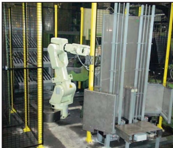
Auch am Testaufbau: Sicherheit stets integriert
